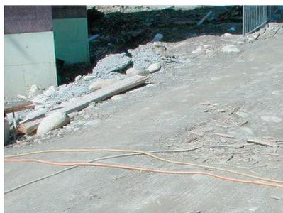
*Ungeschützte Leitungen werden leicht beschädigt und damit zur Gefahr.*
